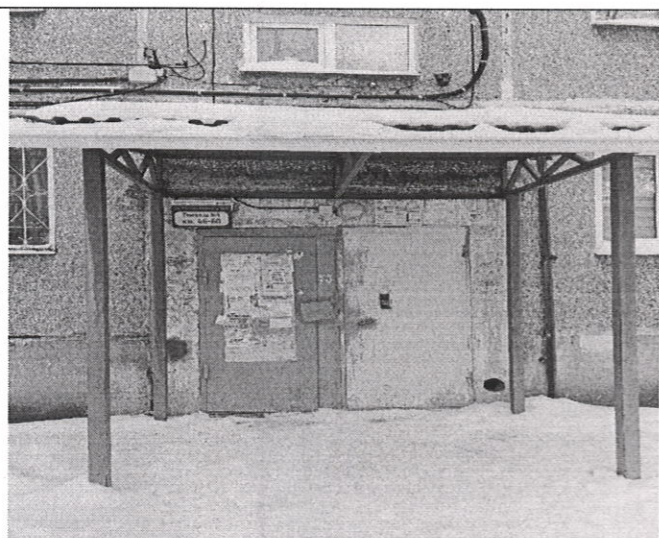
Отдельный вход в подвал ( 4-й подъезд)
