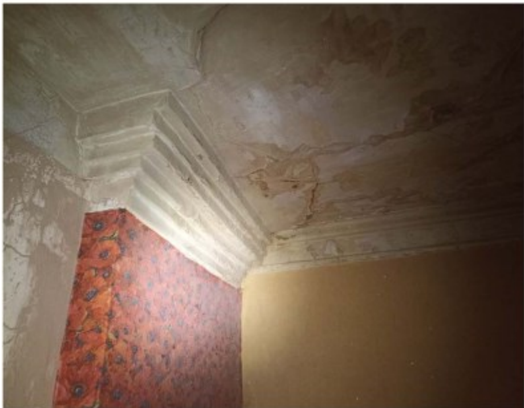
Интерьеры. Полукаменный объем. 2 этаж. Штукатурные потолочные карнизы.
