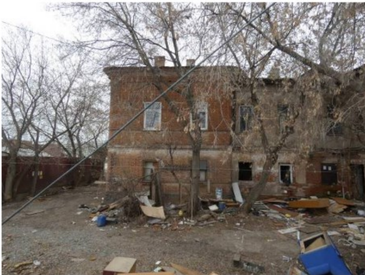
Юго-восточный дворовый фасад.
