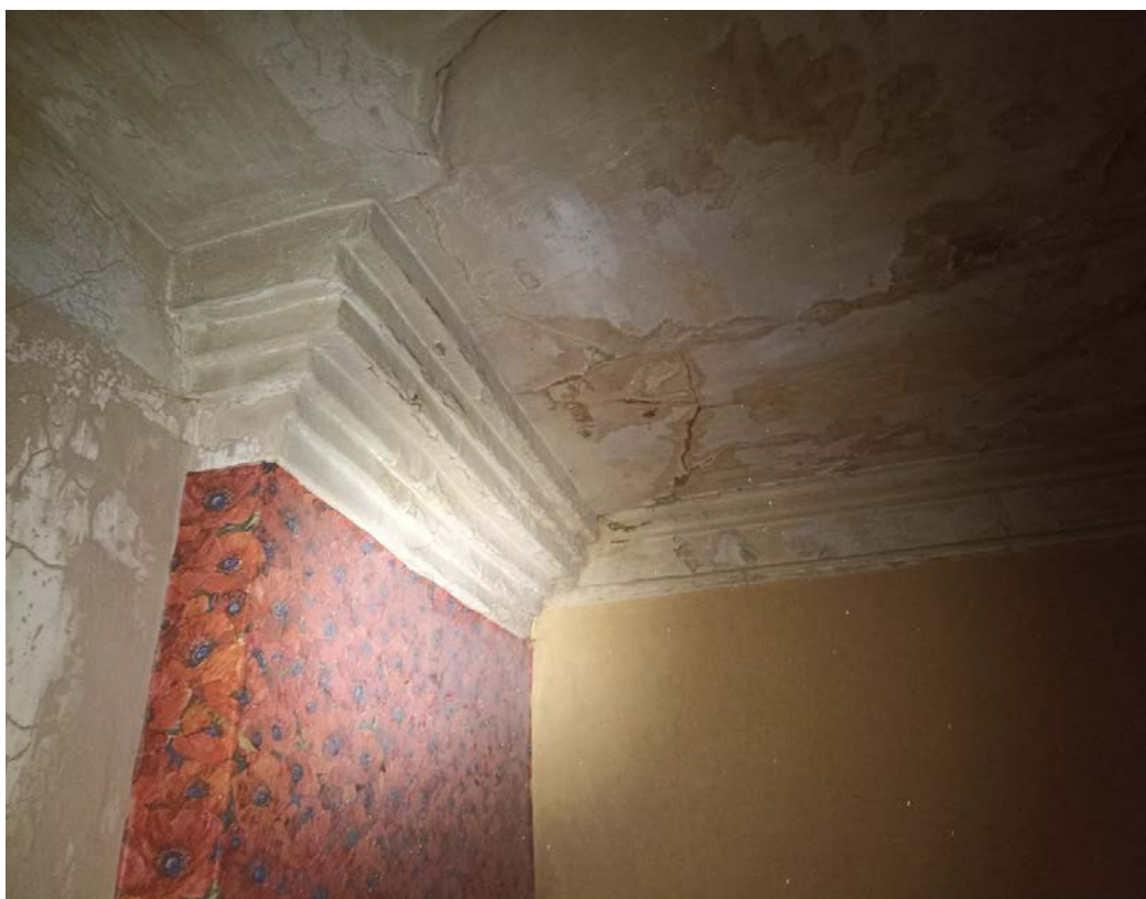
Интерьеры. Полукаменный объем. 2 этаж. Штукатурные потолочные карнизы.
