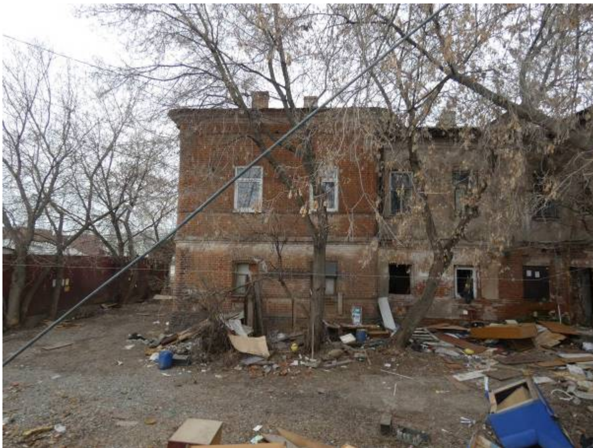
Юго-восточный дворовый фасад.
