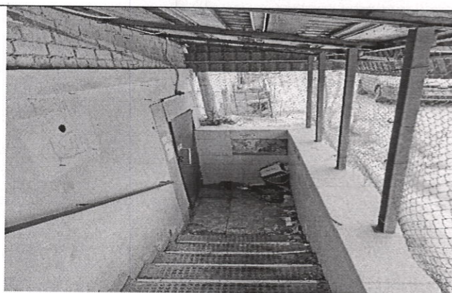
Вход в цоколь (через пристрой - прямок)
