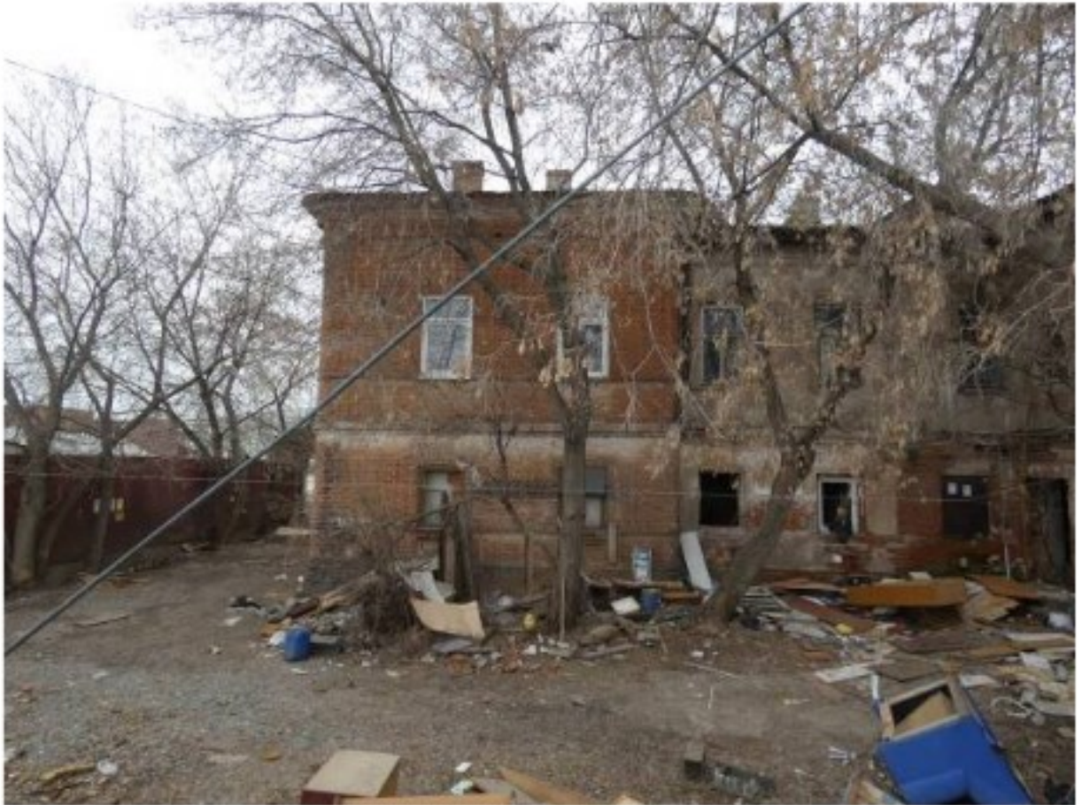
Юго-восточный дворовый фасад.
