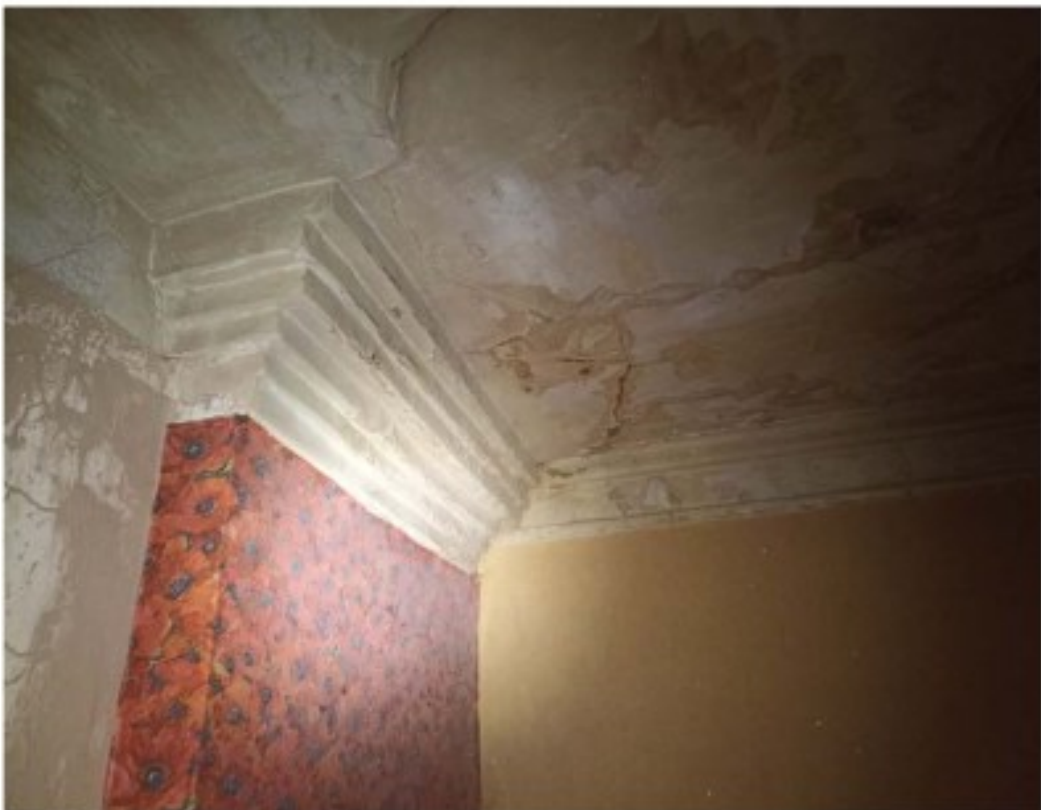
Интерьеры. Полукаменный объем. 2 этаж. Штукатурные потолочные карнизы.
