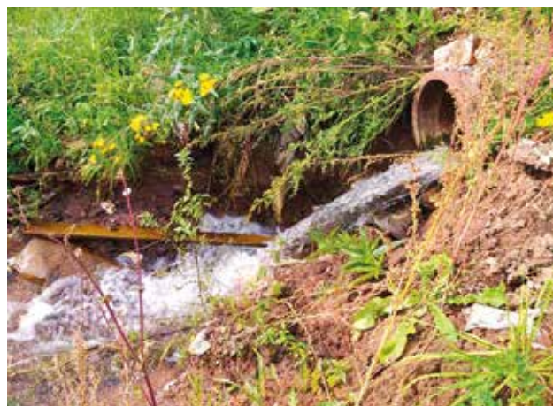
Выходное отверстие трубы
