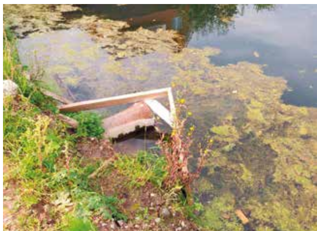
Входное отверстие трубы
