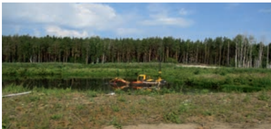
Откачка донных отложений в прудках-отстойниках плавучим земснарядом «Боцман», предназначенным для углубления и очистки водоёмов
