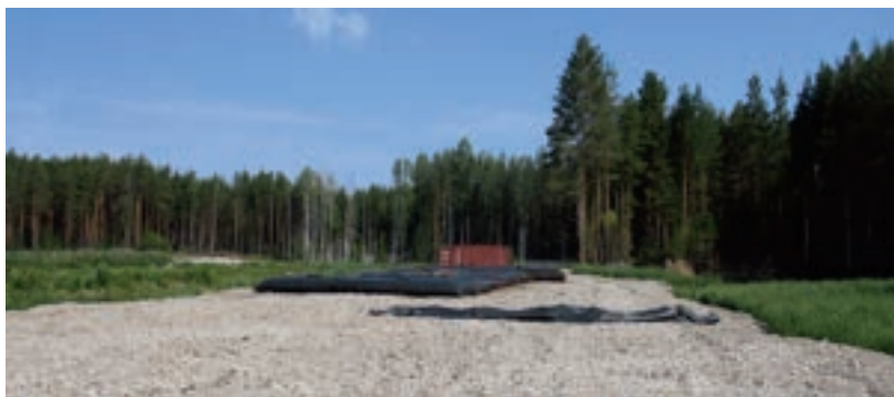
Закачка донных отложений в геотекстильные контейнеры (геотубы) типоразмера ОВ-80ПП-Л15000/Р9700-2ВЦ100/250-8ПЛ, имеющие сертификат соответствия
