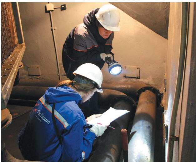
Проверка состояния дренажных систем, агрегатных и межагрегатных помещений
