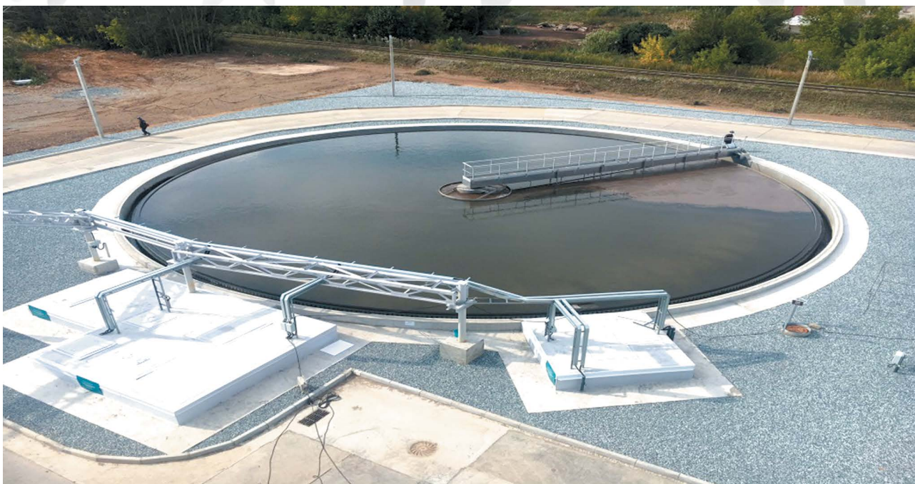
Очистные сооружения «СИБУРА»
