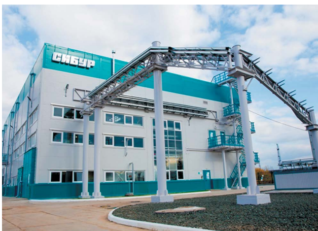
Очистные сооружения «СИБУРа»
